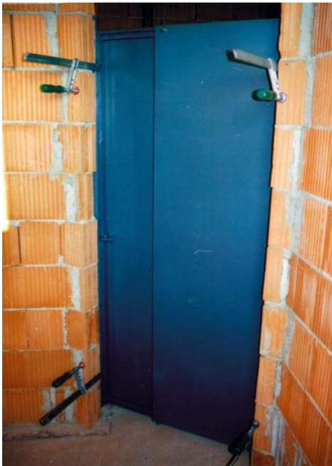
Die Breitenverstellung des Türblattes erfolgt über zwei von aussen nicht erreichbaren Schrauben
