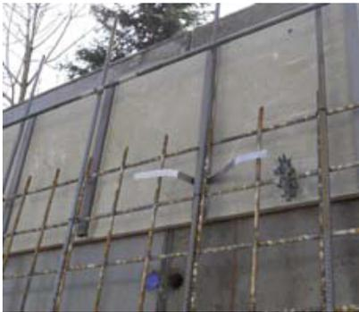
Das LZB Winter Abschaltbrett wird speziell für das Betonieren bei kalter Witterung hergestellt. Zusätzlich zu den PVC-Schwalbenschwanzleisten sorgen speziell geformte Metallanker für eine noch bessere Verankerung im Frischbeton. Diese Metallanker gewährleisten einen optimalen Verbund mit dem Beton auch bei kalter Witterung und damit einhergehenden längeren Aushärtezeiten des Betons.
